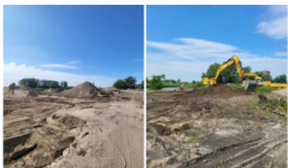
Saneren en aanleggen ondergrondse infrastructuur
