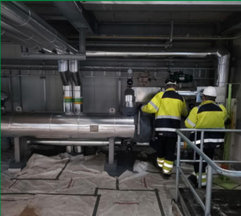
Andrew en Randy Bregman laten lage druk stoom in de warmtewisselaar om de sojaolie op te kunnen warmen
